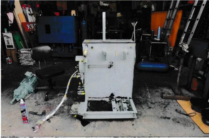
油圧緊張ユニットオーバーホール
