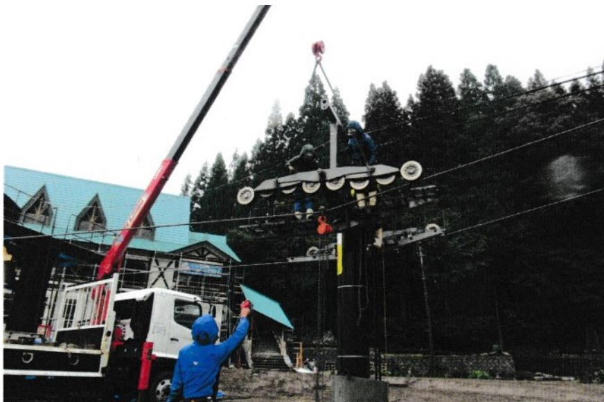
索受修繕工事
