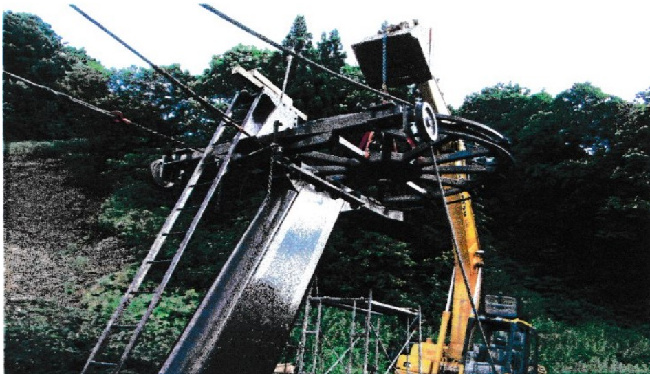
山頂折返し滑車軸受け交換工事
