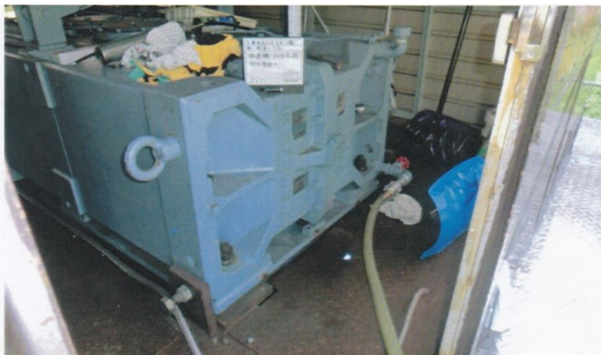
オイル交換工事
