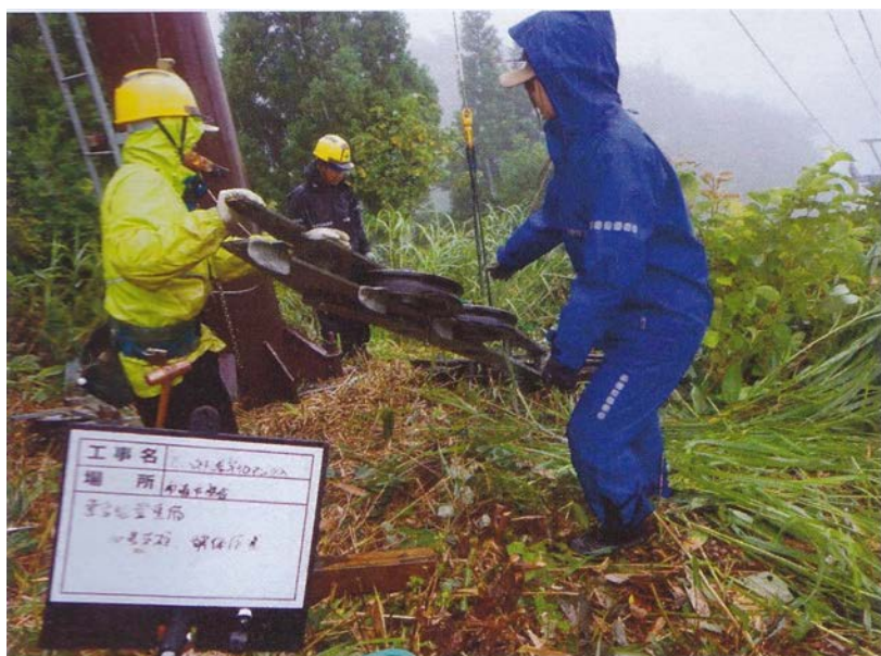
索受整備工事
