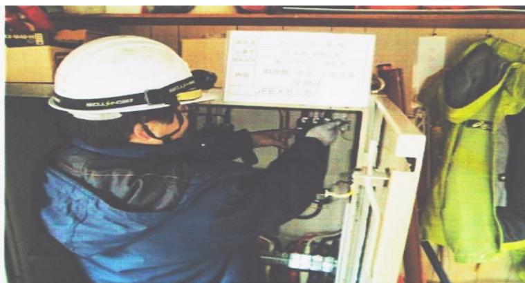
制御盤、操作盤電気部品交換工事
