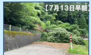
【7月13日早朝】 伏木谷への県道も通行止め
